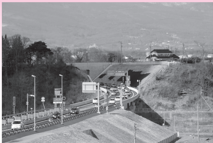
中部横断自動車道開通
