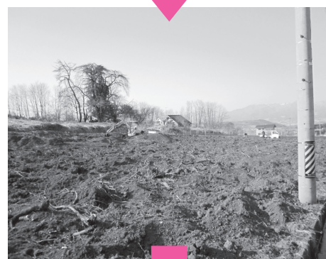
再生作業中②
