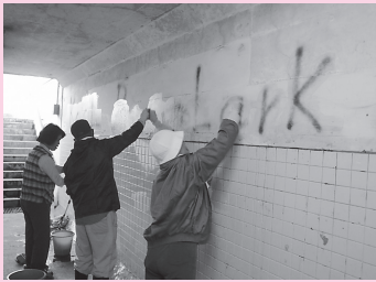
ちとせ地下歩道
