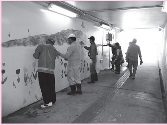
浅間中学校西横断地下道
