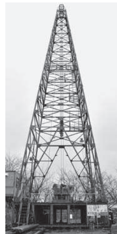
源泉掘削のためのやぐら
