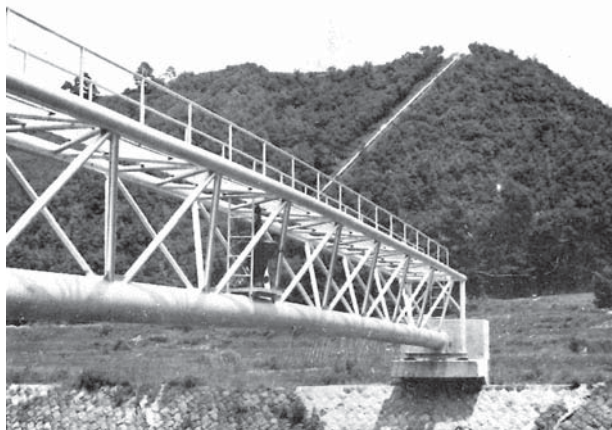
御牧原台地へ水を運ぶ鹿曲川水管橋と望月サイフォン 『県営御牧ヶ原農業水利改良事業竣工記念集』所収
