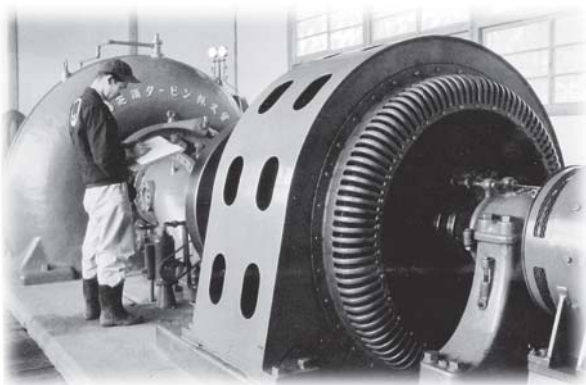
建設当初のタービンと発電機（現在も稼働中） 1955（昭和30）年 森泉一成氏蔵
