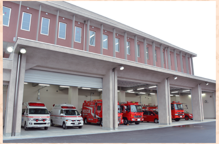
佐久消防署竣工
