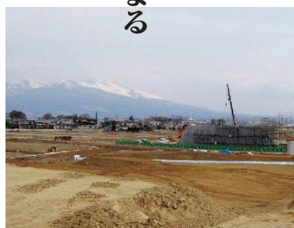
工事の進む中佐都地区
