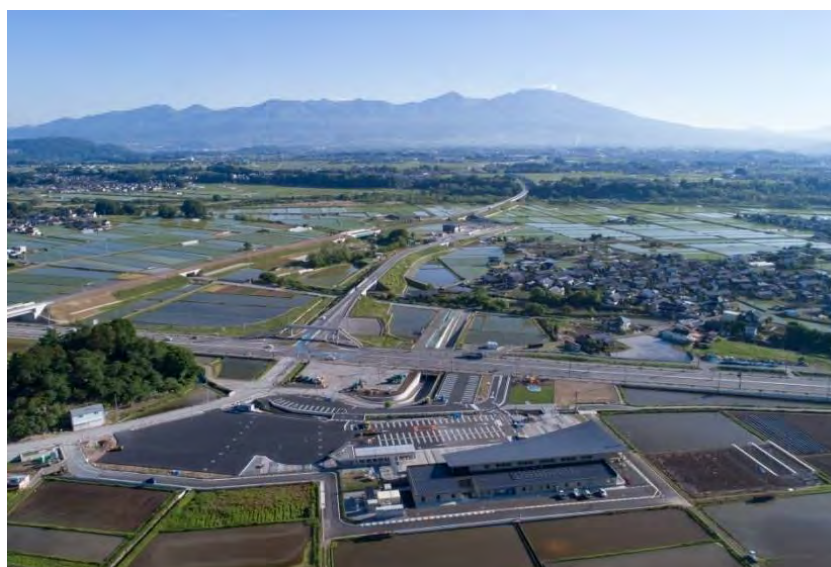
中部横断自動車道佐久南インターチェンジ周辺の様子
