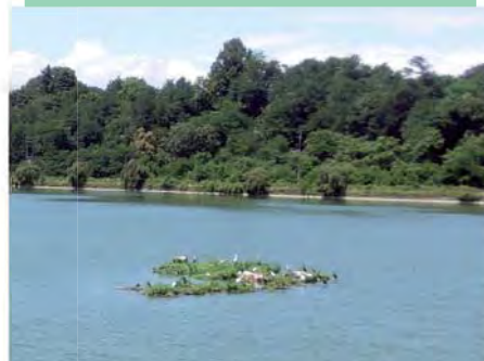
東京電力小諸発電所第一調整池
