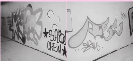
桜井地区の地下道
