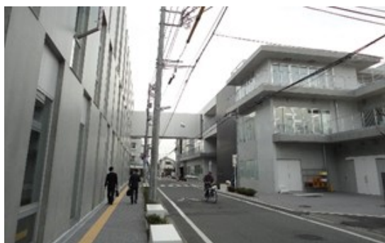
外観（左:校舎棟、右:学習館・講堂棟、中央:3階ブリッジ）
