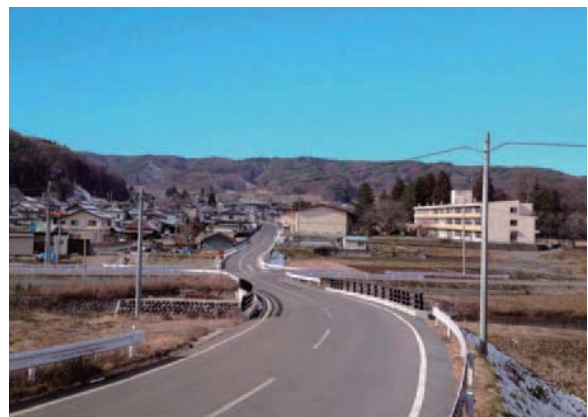
東西幹線第 2 期工区
