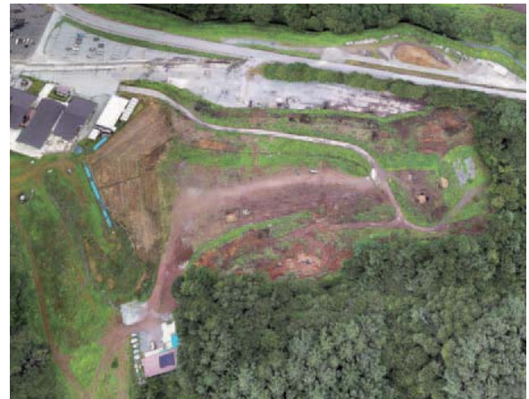
造成工事の始まった新クリーンセンター建設地
