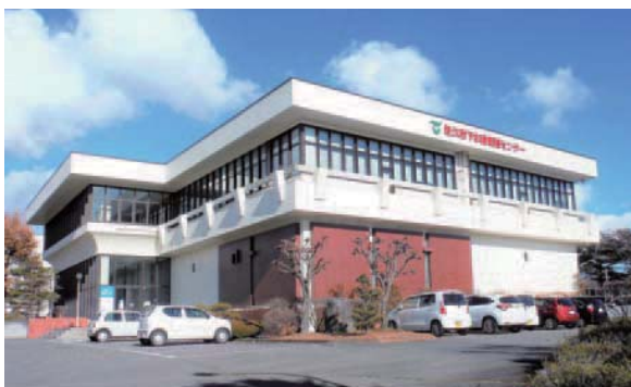
佐久市下水道管理センター
