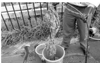
ポンプに絡まる繊維物
