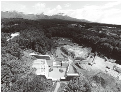
蛇堀川 工事現場状況
