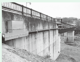
浅科大橋へ污水管を添架
