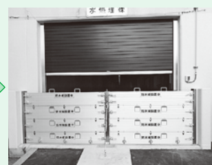
浸水対策として防水板を取付
