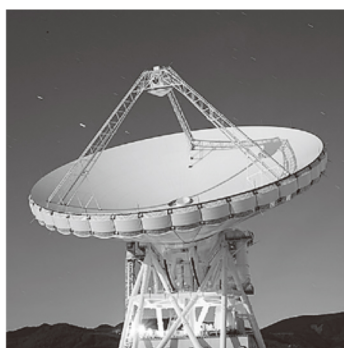
美笹深宇宙探査用地上局 口径54mアンテナ
