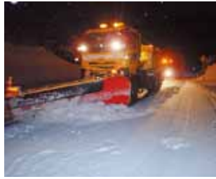
高速道路維持工事（除雪）
