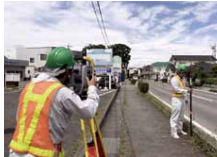
測量作業状況
