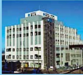
1F～4F くらさわ病院 5F～6F 介護老人保健施設安寿苑
