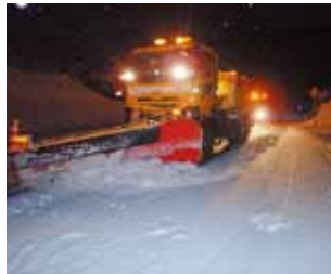
高速道路維持工事（除雪）
