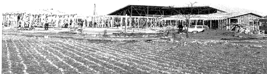
昭和 37 年 野沢地区に建設中の園舎
