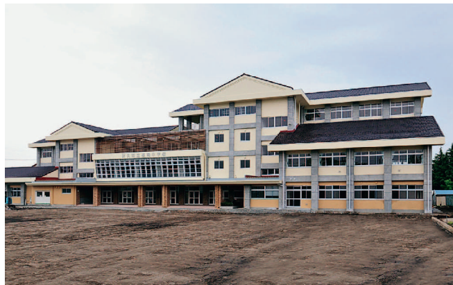
建設が進む浅間中学校
