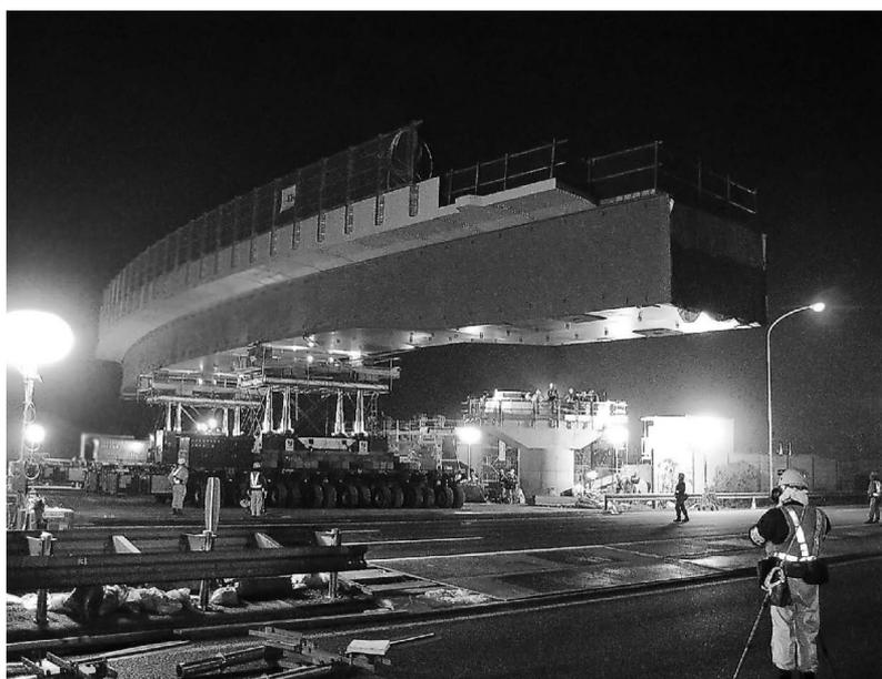
大型多軸移動台車による橋梁架設工事事例（東北道 久喜白岡）
