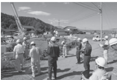
常和区の田子川の改良復旧状況を確認
