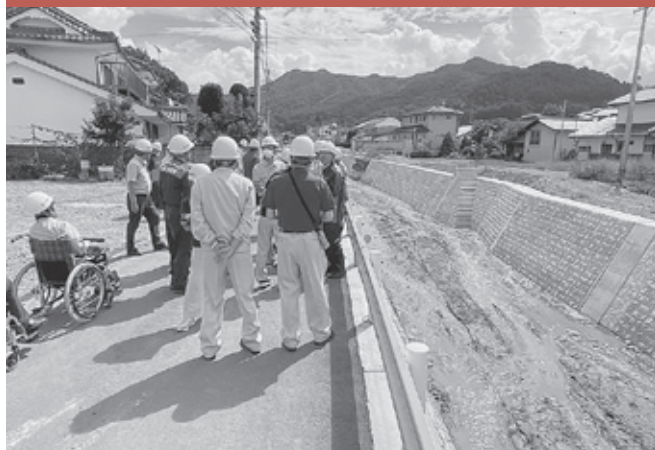
令和元年東日本台風で被災した入澤区谷川の復旧状況を確認
