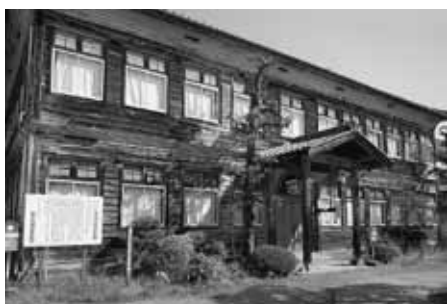
本来の木枠への窓枠復元を待つ旧大沢小学校
