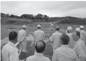
野球場建設予定地を視察
