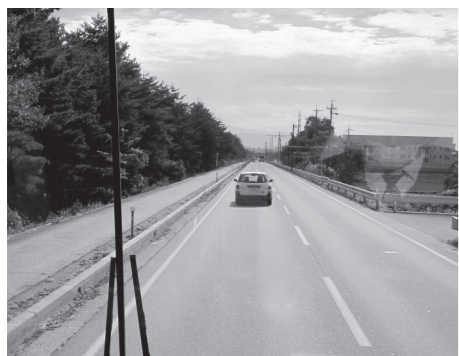
「松本糸魚川連絡道路」高瀬川右岸の現道活用区間を走行
