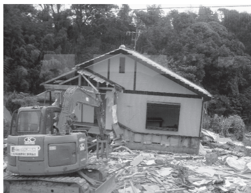
熊本地震の被害の様子
