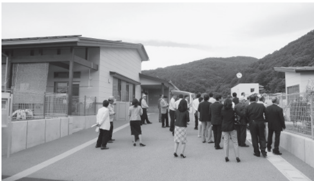
平賀・内山地区新保育所建設事業建築（本体）工事の施工状況
