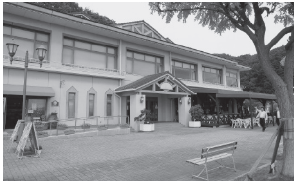
平尾山公園センターハウス改修工事の施工状況
