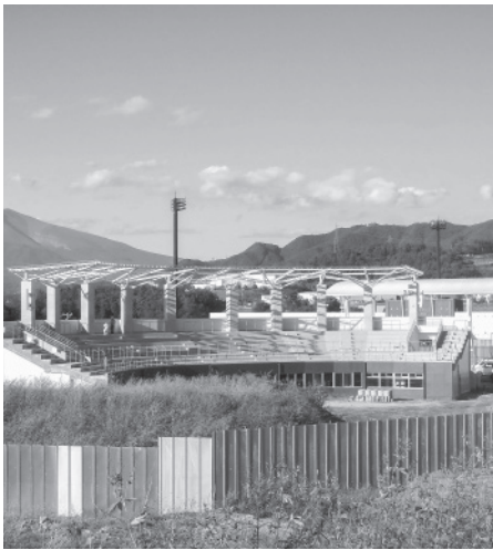
総合運動公園野球場工事の様子
