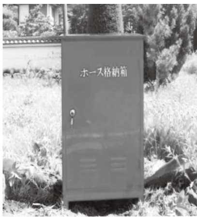
市内に設置されているホース格納箱
