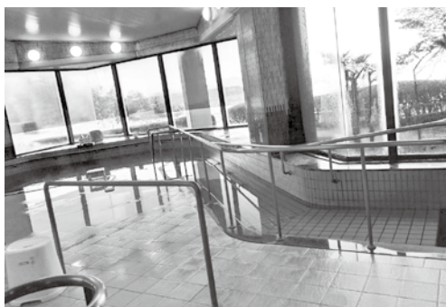
風呂用車いすに乗り換え、スロープで入れる大浴場 (栃木県障害者保養センター那珂川苑)
