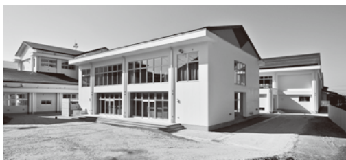
岩小の多目的ホール等完成、残すはグラウンド整備のみ
