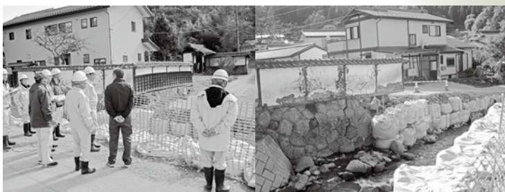
田子川氾濫箇所をトンパックで仮復旧（常和北・南区）
