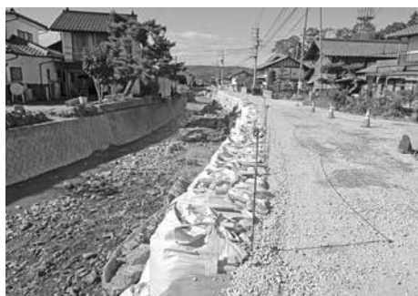
仮復旧された谷川沿い
