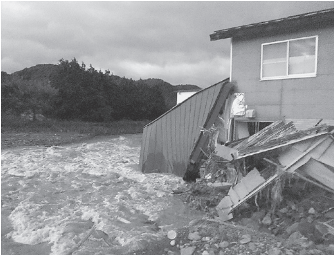
志賀川の被災状況
