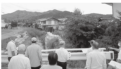
河川等災害関連事業に伴い整備される市道の現地確認
