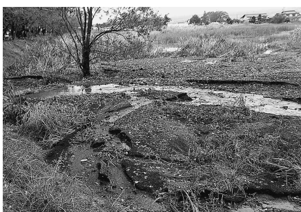
令和元年東日本台風直後の洞源湖
