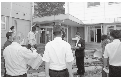
野沢会館第1期解体工事箇所の現地調査
