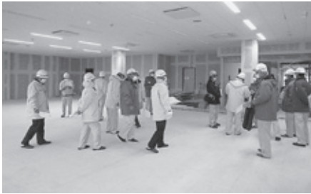
建設が進む浅科支所複合施設
