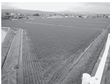
復旧工事が進み、作付けされた石神区の水田
