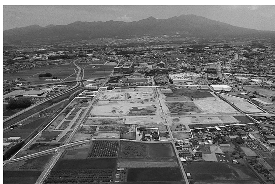
造成工事が進む佐久平駅南土地地区画整理事業 (令和3年6月現在)
